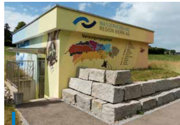
Neue Pumpstation des Wasserverbundes Region Bern AG in Ortschaftswaben Foto: Urs Thüer
